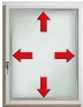
Tabule skla se vsadí do rámu a vycentruje.
