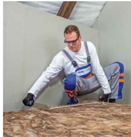
3. Jednotlivé pásy izolace se řezou o jeden až dva centimetry širší než je naměřená mezera mezi krokvemi. Řez vedeme kolmo k rovině izolace.
