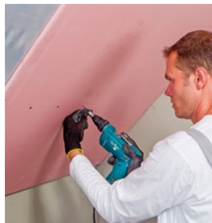
9. Montáž sádrokartonu. Vysoce účinná parozábrana Homeseal LDS 100 omezuje vznik netěsností v místě průniku vrutů.
