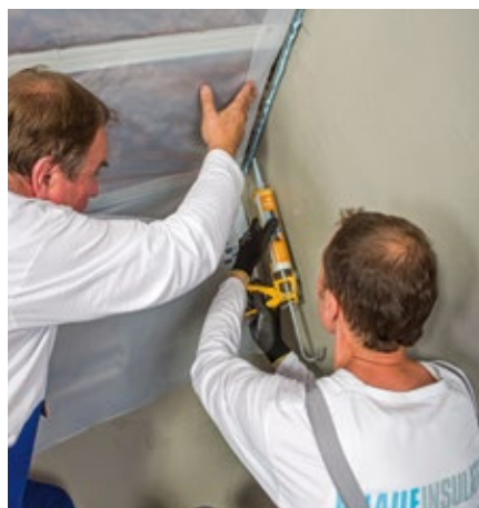
8. Parozábrana Homeseal LDS 100 se k přiléhajícím stavebním konstrukcím dotěsňuje pomocí těsnícího tmelu Homeseal LDS Solimur nebo Homeseal LDS těsnícího pásky, vzájemné spoje pomocí pásky Homeseal LDS Solifit nebo Homeseal LDS Soliplan.
