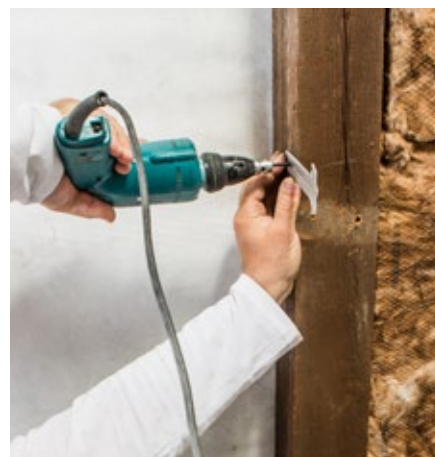
6. Montáž nosné konstrukce podhledu s použitím krokrových závěsů.
