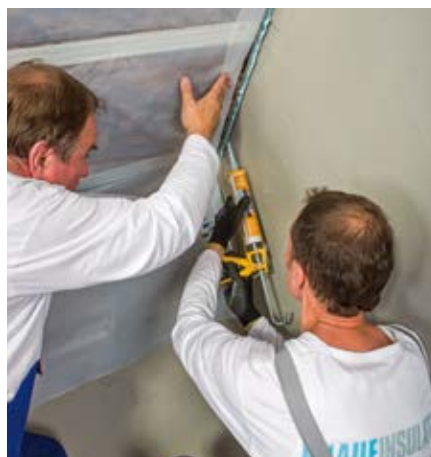
8. Parozábrana HOMESEAL LDS 100 se k přiléhajícím stavebním konstrukcím dotěsní pomocí těsnícího tmelu HOMESEAL LDS Solimur nebo HOMESEAL LDS Kleberaube, vzájemné spoje pomocí pásky HOMESEAL LDS Solifit nebo HOMESEAL LDS Soliplan.
