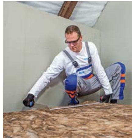
3. Jednotlivé pásy izolace se řezou o jeden až dva centimetry širší než je naměřená mezera mezi krokvi. Řez vedeme kolmo k rovině izolace.
