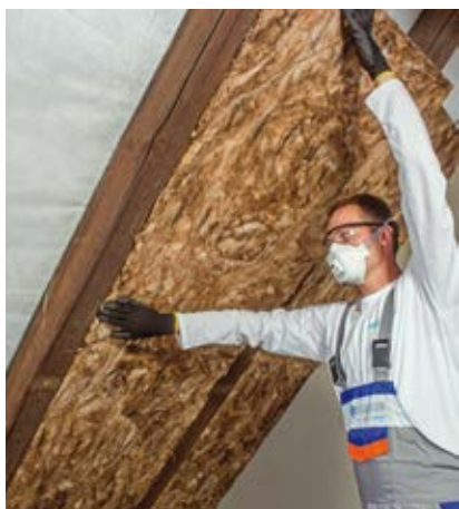
4. Správně naformátovaná izolace UNIFIT se snadno vkládá mezi krokve. V konstrukci následně drží bez nutnosti jakékoliv dodatečné fixace.
