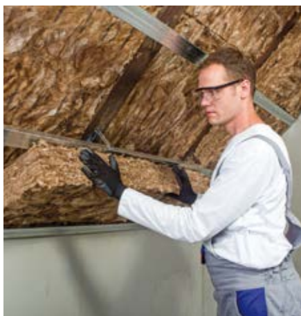
7. Vrstva izolace pod krokvi se vkládá do nosného roštu sádrokartonového podhledu.
