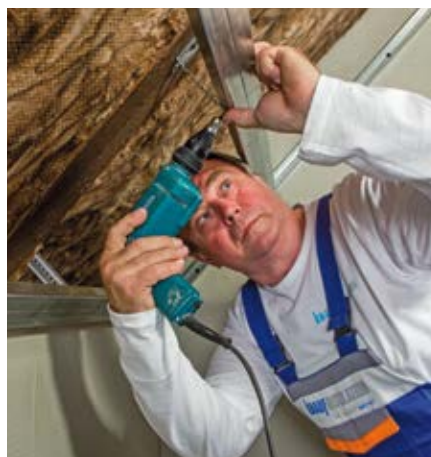
5. Montáž nosné konstrukce podhledu s použitím přímých závěsů.
